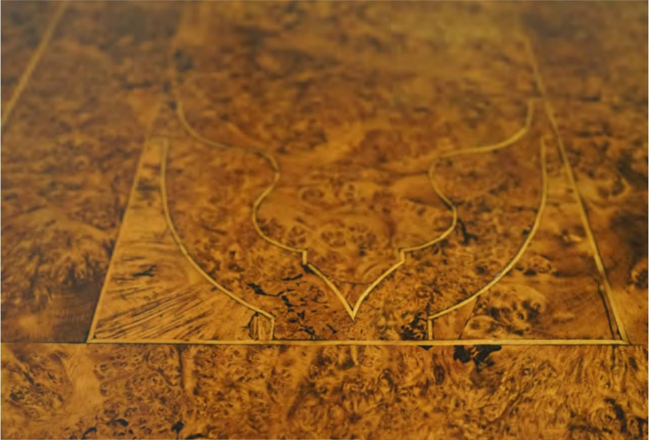
Die Kommode ist fertig restauriert. Der bernsteinfarbende Ton kommt wieder zum Vorschein. Die fehlenden Funierstücke sind ersetzt und farblich angepasst. Sie fügen sich unauffällig in das Gesamtbild der Kommode ein. Sämtliche Beschläge sind gereinigt und strahlen im goldgelben Ton des Messings. Die Klauenfüße wurden mit Blattgold vergoldet. Auf der Holzoberfläche wurde in mehreren Arbeitsschritten eine deckende Schellackhandpolitur aufgetragen.
