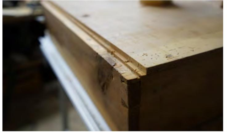
Links: Die tiefe Abnutzungen in der Laufleiste. Rechts: Der gefälste Schukastenboden.
