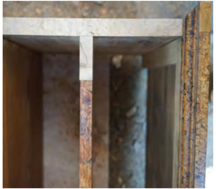
Bearbeitung. Unten (rechts): Die Überstände des neue Funiers müssen für die genaue Passform noch geschliffen werden.
