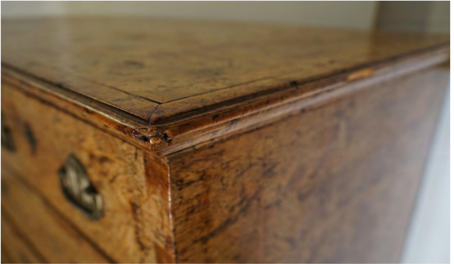
Oben und unten: Detailaufnahme der fehlenden Funierstücke im Leistenbereich des Deckblatts sowie Sockels.
