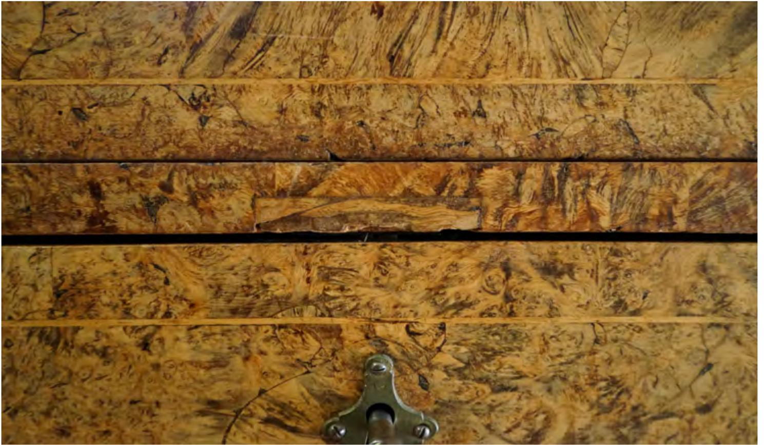
Oben und Unten: Schäden an der Front der Kommode im Bereich der Schubfächer.
