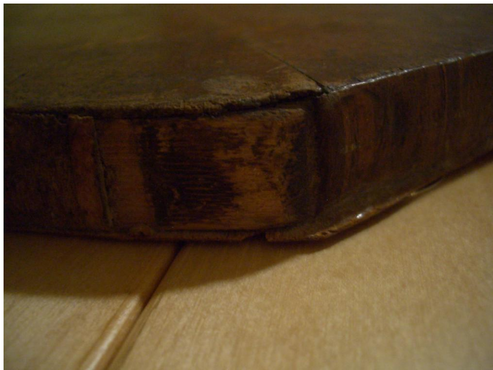
Abbildung 21: Überstand des Unterfurniers
