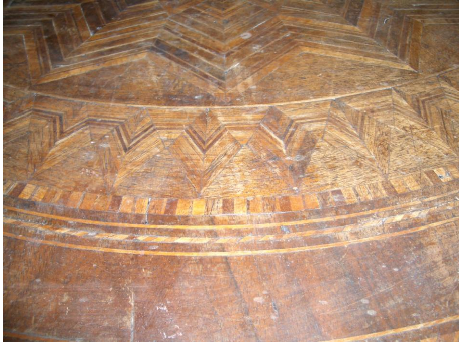
Abbildung 18: Oberflächenschäden
