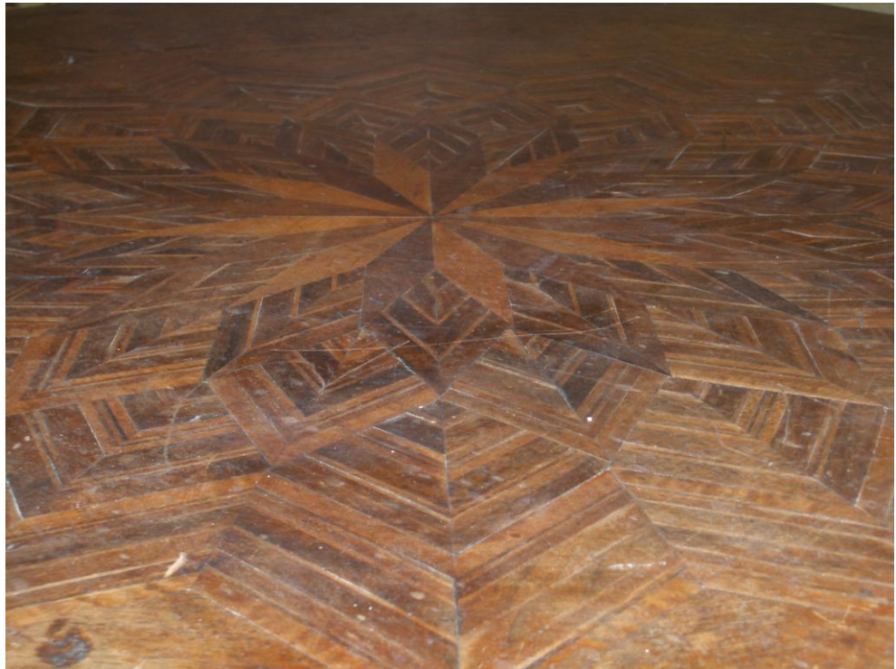
Abbildung 20: Oberflächenschäden
