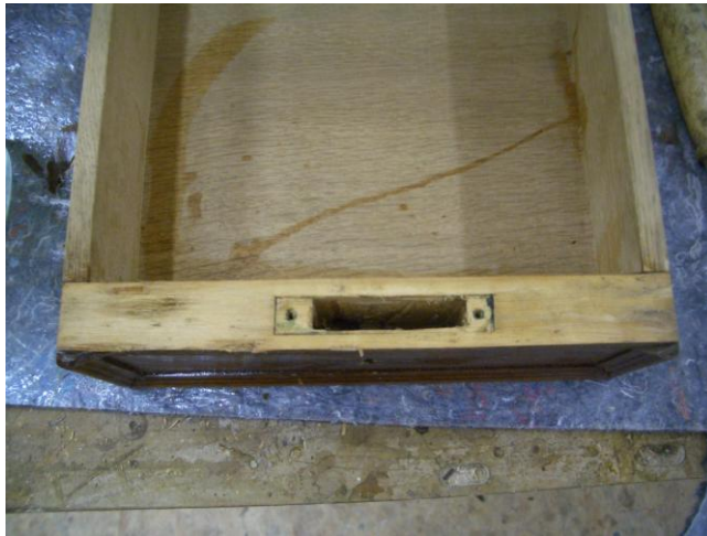
Abbildung 2: Schubkasten Furnier entfernt
